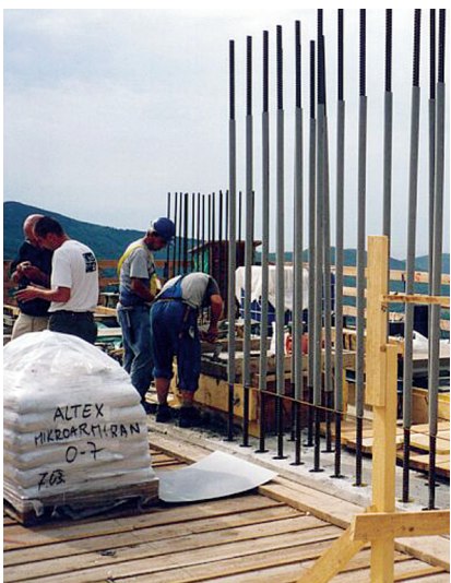
Zalivanje ležišta na vijaduktu Črni Kal.
