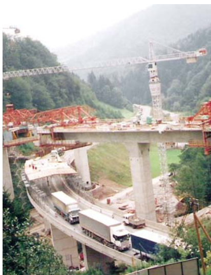
Viadukt Baba, Trojane.
