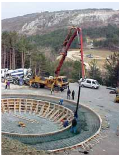
Temeljni bunar vijadukta Črni kal.
