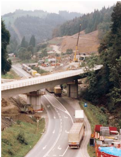
Viadukt Zlokarje, Trojane.
