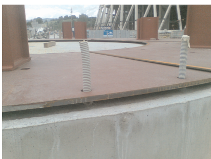
TE Šoštanj: pred podlitvjem s Tekamal Alteks SCC 0-3
