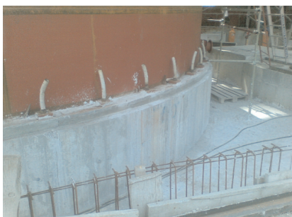
TE Šoštanj: po podlitju s Tekamal Alteks SCC 0-3
