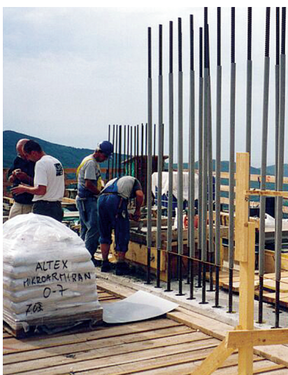
Zalivanje ležišč na viaduktu Črni Kal.
