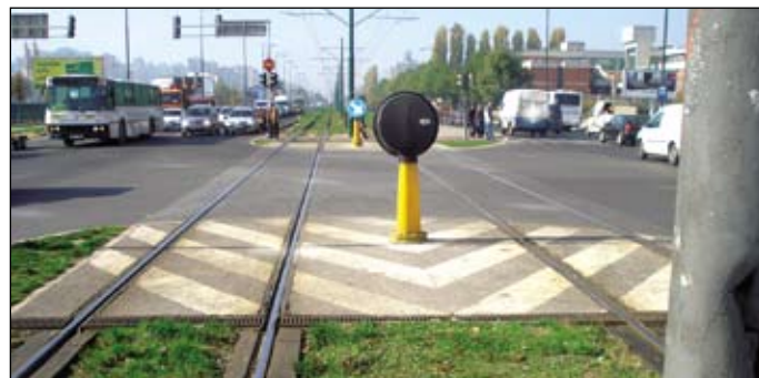
Sanacija prehoda čez železniško progo
