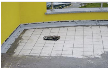
Priprava podlage na terasi za nanos polimerno-cementne hidroizolacije pri sanaciji (že nameščeni robni tesnilni trakovi)
