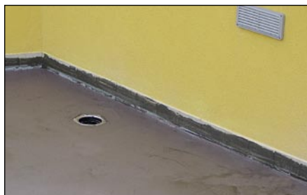
Pogled na izveden nanos polimerno-cementne hidroizolacije s talnim odtočnim sifonom pred polaganjem zaključne keramične obloge
