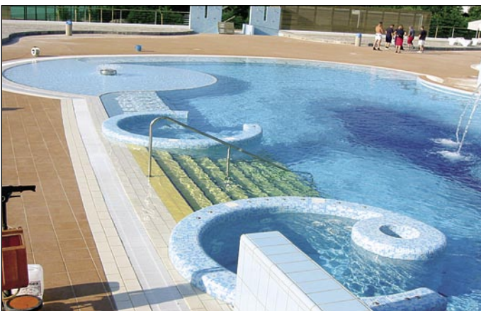
Pogled na dokončan plavalni bazen, pri katerem je bila za naknadno notranjo zaščito vodotesnega betona, talne plošče in sten pred nanašanjem keramičnih ploščic in steklenega mozaika uporabljena elastična polimerno-cementna hidroizolacija
