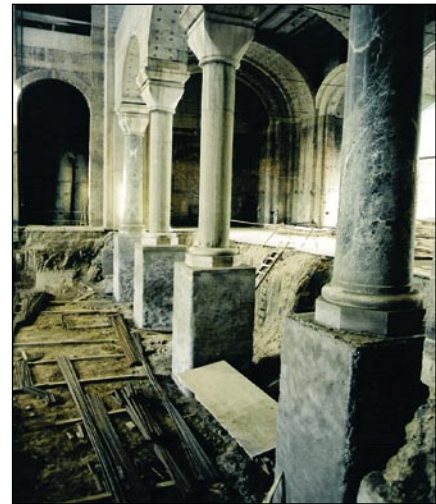
Hidroizolacija temeljev s premazom Tekamal Hidroizol S na objektu cerkev sv. Save v Beogradu
