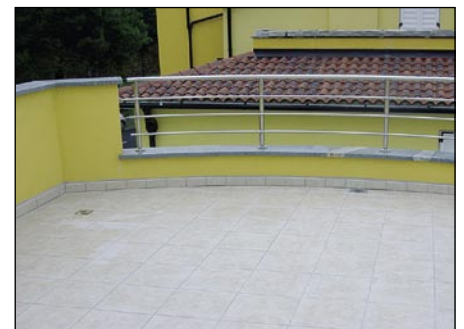
Pogled na zaključno izvedeno površino keramične obloge po sanaciji terase
