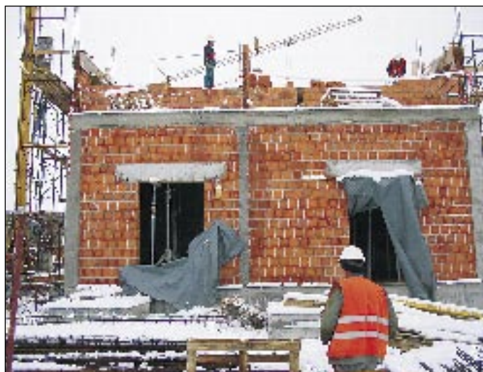
Zimsko zidanje z opečnimi bloki na objektu Mednarodni železniški mejni prehod MŽMP v Dobovi, gradil Begrad d.d. (dodatek za podaljšane malte pospešilo vezanja Cementol Omega P, TKK Srpenica)
