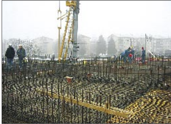
Zimsko betoniranje AB plošče stanovanjskega objekta Antonov trg v Kranju, gradil Gradbinec GIP d.o.o. (uporabljen kemijski dodatek pospešilo Cementol B Novi, TKK Srpenica)
