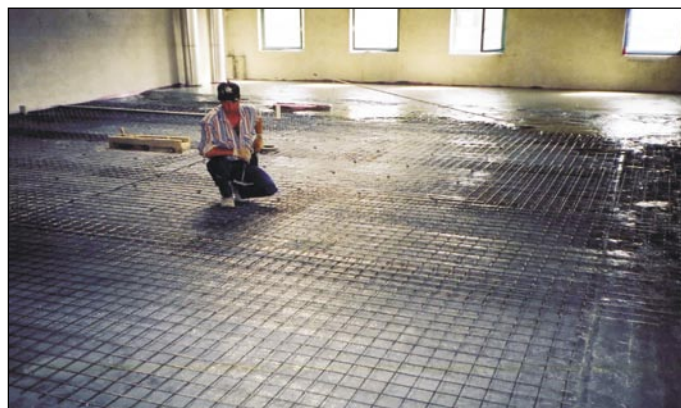
Pogled na že nanosen počasno vezoči dvokomponentni vezni premaz na osnovi epoksidne smole brez topil za izboljšanje prijemljivosti med svežim in starim betonom ter polaganje gradbene varjene mrežne armature na ustrezne distančnike.
