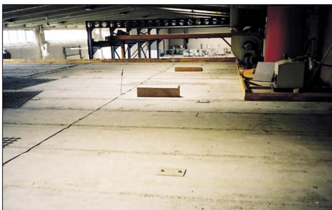
Strop tehnične medetaže iz PVP plošč pred pripravo za lepljenje tlačnega dela dobetonirane plošče tlaka (na sliki so dobro vidne že zalite rege med ploščami).
