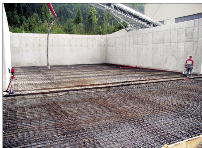
Stanje pred betoniranjem talne plošče zunanjega platoja deponije peska
