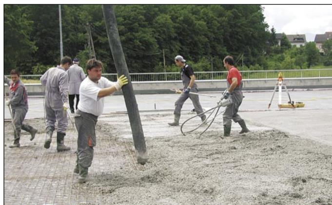
Vgradnja svežega betona plošče zunanjega parkirišča na strehi trgovskega centra
