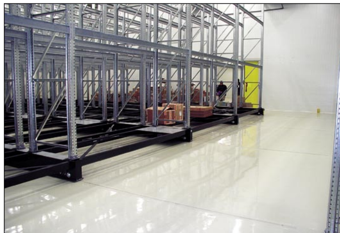
Pogled na neskrčljiv cementnobetonski tlak z vgrajenimi tirnicami ter z zaključno samorazlivno epoksidno prevleko paletnega prevoznega visokoregalnega skladišča v objektu Hladilnica »Hmezad trgovina d.o.o.« v Žalcu
