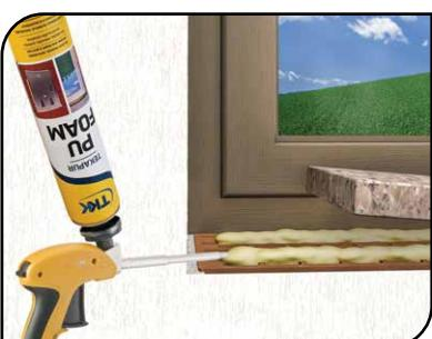
**Tekapur Low Expansion gun grade** je jednokomponentna poliuretanska pjena koja stvrdnjuje pomoću vlage iz zraka. Posebna formulacija daje pjenu koja ima veoma nisku ekspanziju, zbog čega je odgovarajuća za lijepljenje, pričvršćivanje i brtvljenje.
