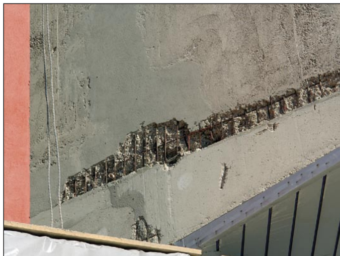
Priprave na sanacijo betonskega zidu hotela Histron pri Portorožu.
