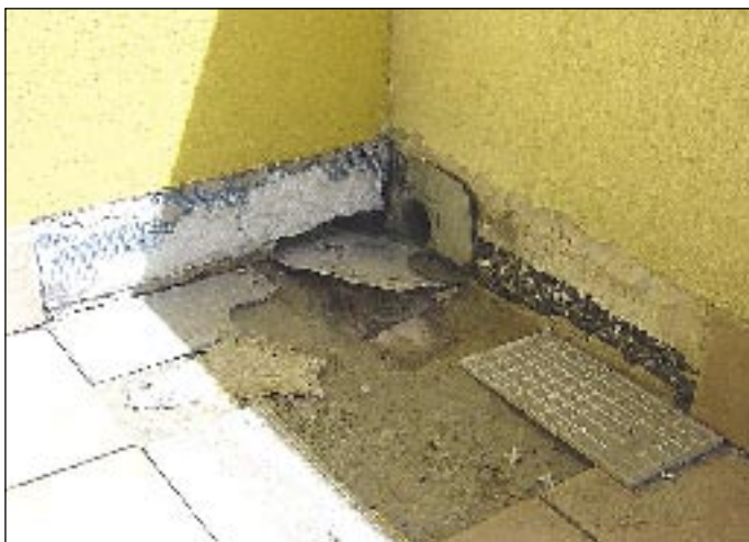
Take nepravilne rešitve odtokov in zamakanja vode pod keramično oblogo lahko pravilno in kakovostno rešimo s fleksibilno mineralno hidroizolacijo.
